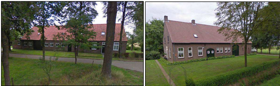
Figuur 16: Impressie van huidige bebouwing aan Berkeindje 11 (links) en Berkeindje 3 (rechts) (Bron: Google Maps)
