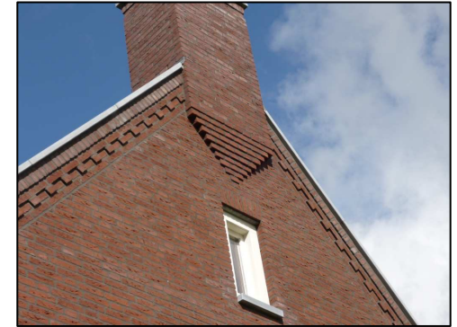
Afbeelding: Voorbeelden van een ambachtelijke detaillering in metselwerk
