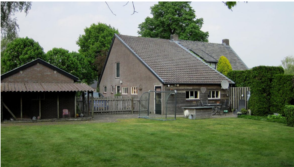
B13. Aan de achterzijde van de huidige bedrijfswoning Hoijserstraat 13 is goed te zien dat het dakvlak uit twee delen bestaat, waarbij het dakvlak over de uitbouw hoger is om nog voldoende bruikbare ruimte te creëren. Naast de woning staat een klein bijgebouw. Achter de woning zijn de kruinen van de bestaande, grote bomen te zien. Deze zullen bij de omvorming naar een groenpleintje waar mogelijk behouden blijven.
