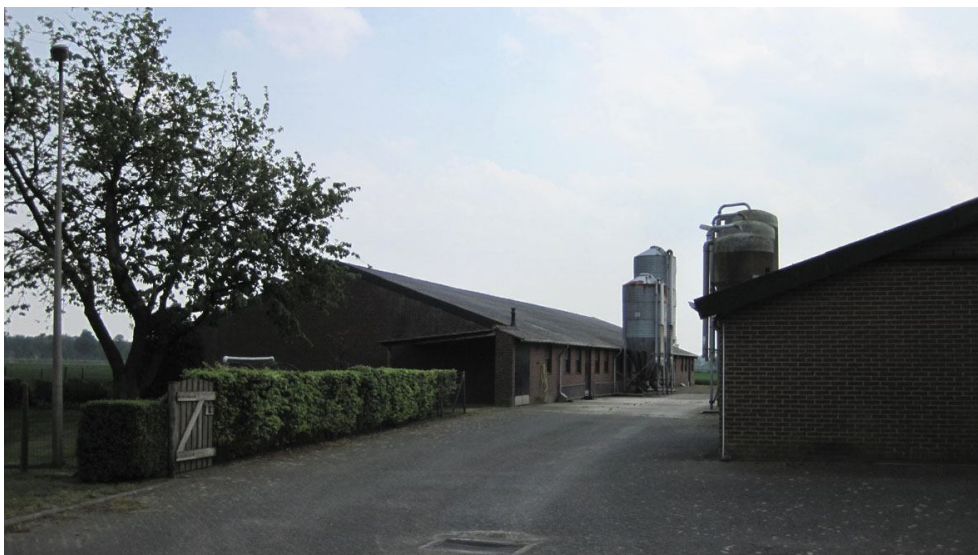
B11. De bestaande bedrijfsbebouwing zal worden afgebroken om plaats te maken voor de nieuwe woningen. De bestaande bebouwing bestaat uit twee langgerekte, lage stalgebouwen met hoge silo's aan weerszijden van een bedrijfspad. De stalgebouwen liggen direct achter de bedrijfswoning en de daarbijbehorende tuin.
