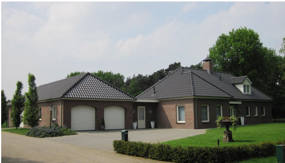
afbeelding 7. Hoijsersstraat 15a is gebouwd naar voorbeeld van nummer 15 met vastgebouwd groot bijgebouw.
