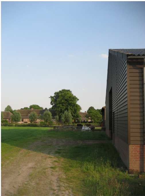
Achterzijde bestaande hal
