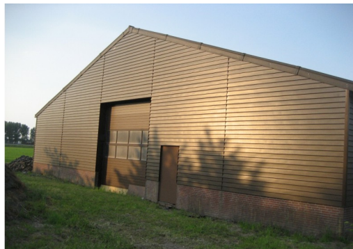
Voorzijde bestaande hal
