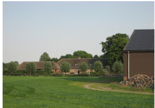
Zicht op woonboerderij en schuur (Boomen 9)
