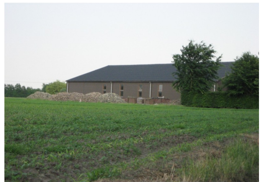
Gevelbeeld van de bestaande hal
