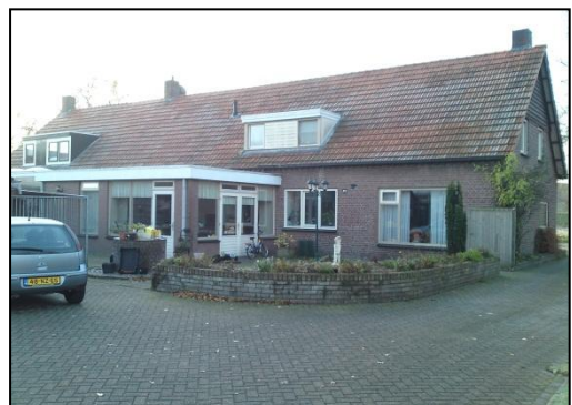
Foto's bestaande situatie
