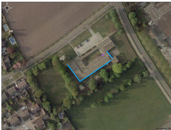
Figuur 1. Luchtfoto van de onderzoeklocatie met potentiële verblijfplaatsen achter betimmeringen/zonweringen (blauwe lijn); paarse lijn geeft de open stootvoegen aan
