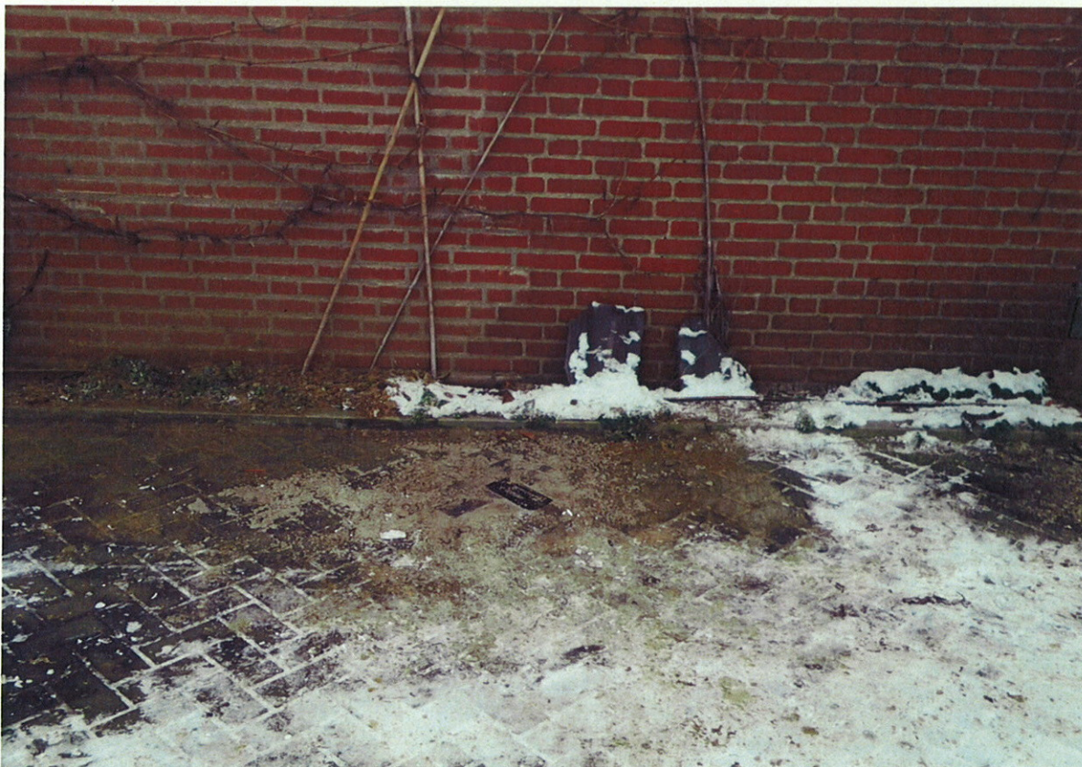
peilbuis bij vml bovengrondse tank (B)
