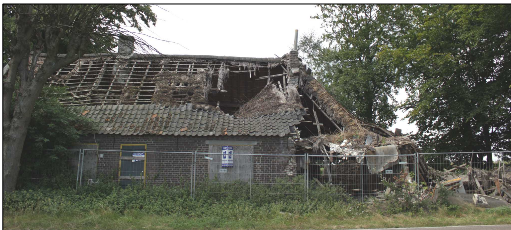
Figuur 8: Beeld van de vervallen woning aan Kerkendijk 60 voor sloop van de woning.
