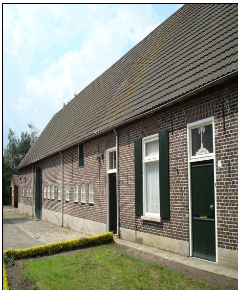
Figuur 23: Voorgevel van het hoofdgebouw
