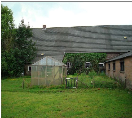
Figuur 24: Achterzijde hoofdgebouw met te slopen aanbouw
