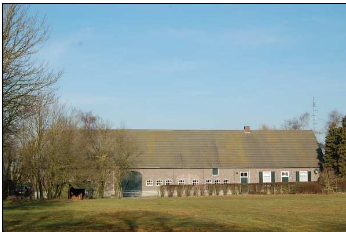
Figuur 6: Langgevelboerderij aan Moorsel 3
