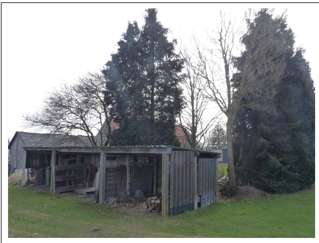
Foto 4. Te slopen schuur perceel Kuilvenweg nr. 4
