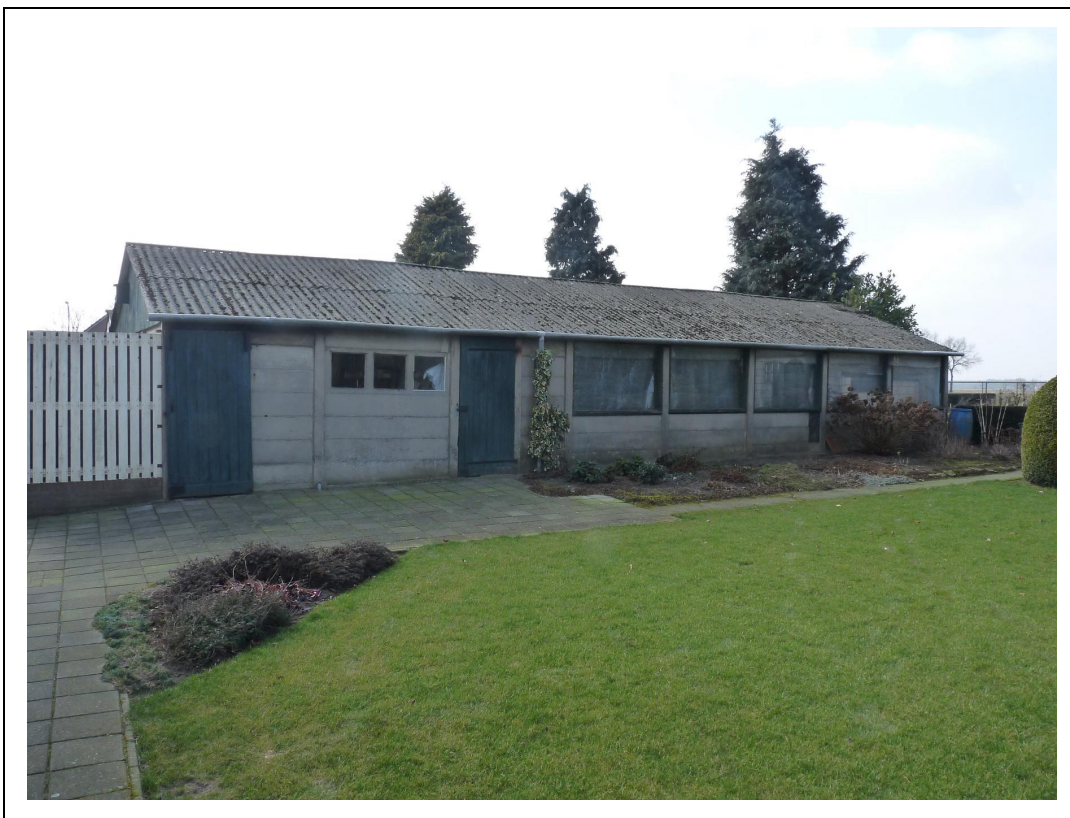
Foto 7. Te slopen schuur perceel Kuilvenweg nr. 4
