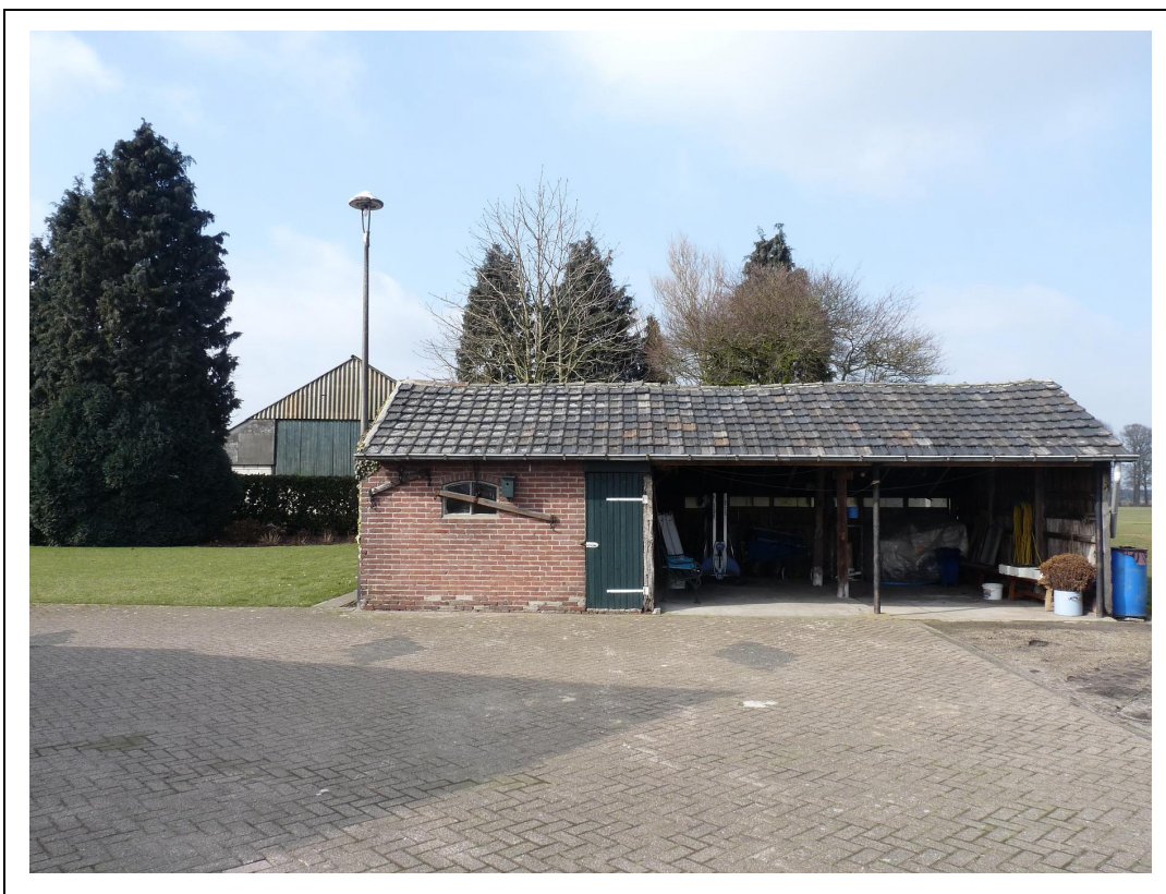
Foto 3. Te slopen schuur perceel Kuilvenweg nr. 4
