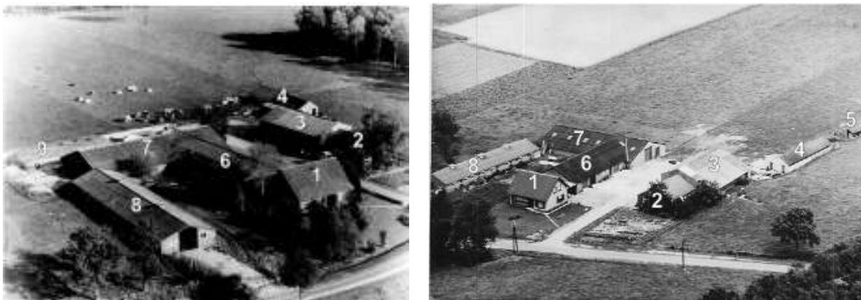
Figuur 4: luchtfoto oorspronkelijke situatie agrarisch bedrijf
