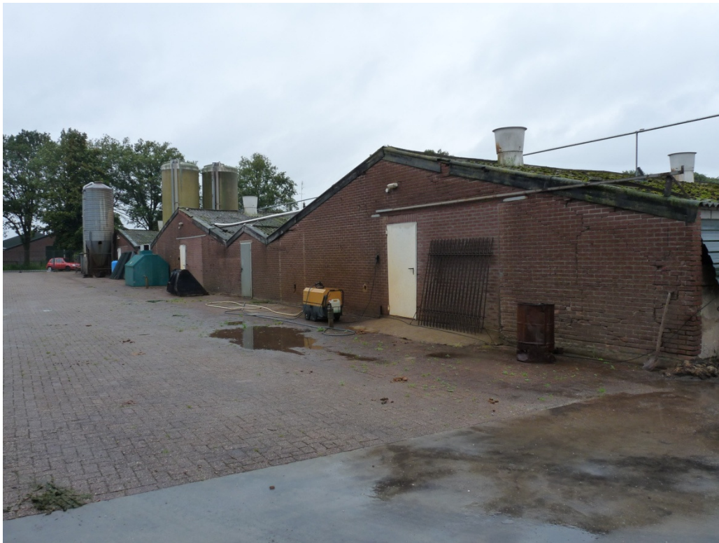
Foto 2. Te slopen stallen ten oosten van de bedrijfswoning
