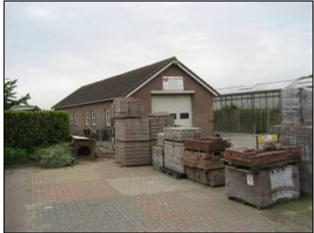
Opslag bouwmaterialen en bedrijfsgebouw
