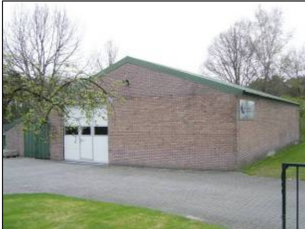
Vooraanzicht terrein met bedrijfsgebouw
