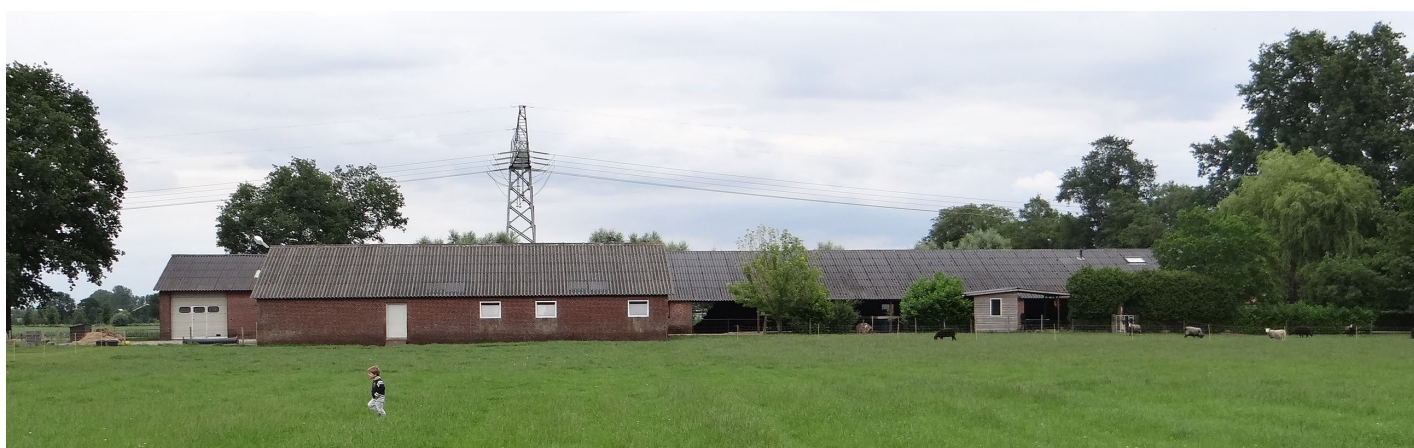
Afbeelding: Westzijde, wordt haag geplaatst.
