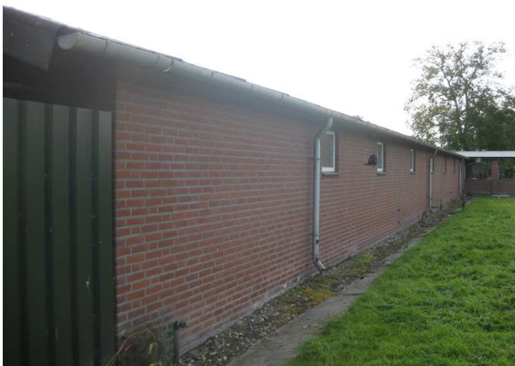
Figuur 29. Hemelwaterafvoer in de huidige situatie
