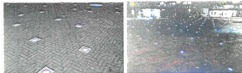
Verlichting in multifunctioneel deel om parkeerplaatsen te markeren
