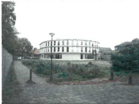
Appartementen op de school
