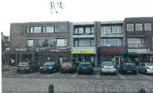
Bestaande lage pleinwand Mercuriusplein t.p.v. Rabobank
