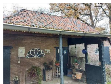
Figuur 2.15 Buitenzijde schuur en bakhuis (oude gedeelte) behorende bij opstal 3.
