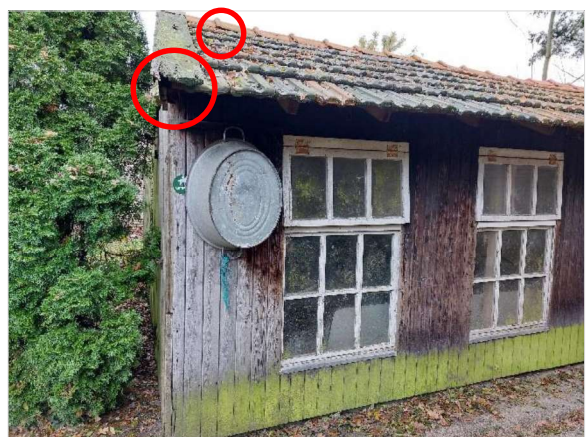
Figuur 5.7 Openingen bij de dakrand en dakpannen van opstal 4.
