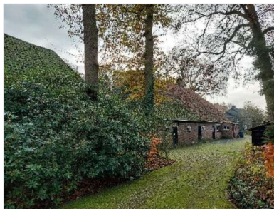
Figuur 2.7 Boerderij (opstal 2) gezien vanaf het noordwesten.
