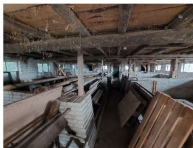
Figuur 2.5 Binnenzijde schuur (opstal 1).
