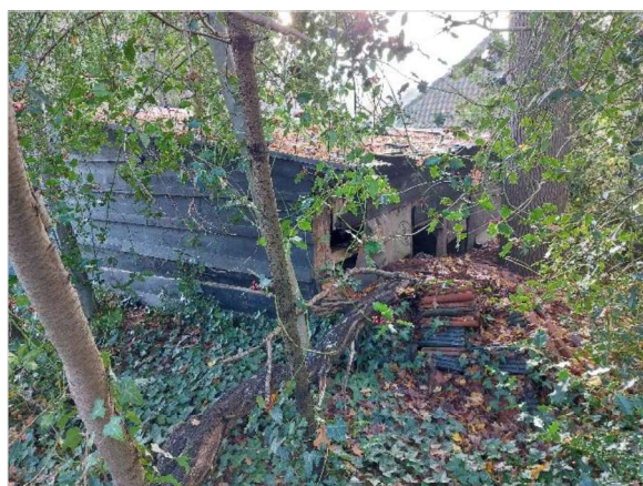
Figuur 5.14 Openingen aan de achterzijde van de carport (opstal 3).
