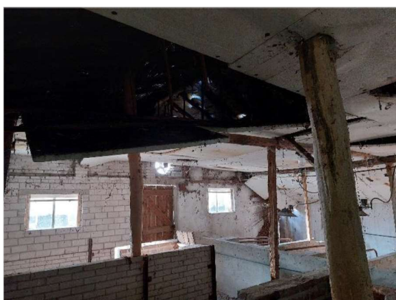
Figuur 5.6 Losse platen van de zolder bij de voormalige varkensstal (opstal 3).
