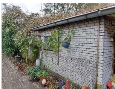
Figuur 2.10 Voormalige varkensstal behorende bij opstal 3.
