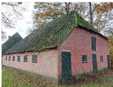
Figuur 2.4 Schuur (opstal 1) gezien vanaf het oosten.
