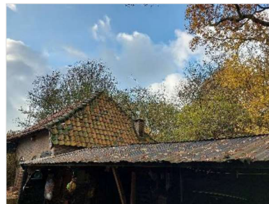
Figuur 2.9 De carport behorende bij opstal 3.
