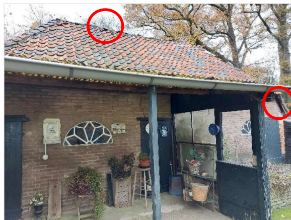
Figuur 5.9 Geschikte ruimtes bij de dakpannen en de dakrand bij het oude gedeelte van opstal 3.
