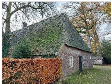
Figuur 2.8 Boerderij (opstal 2) gezien vanaf het oosten.
