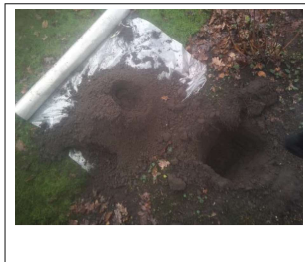
Foto 16. Asbestinspectiegat C14
