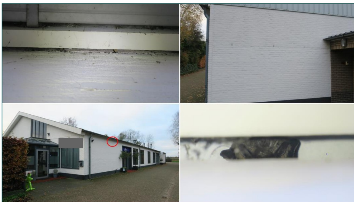
Figuur 3.1 Invliegopeningen voor gebouw bewonende vleermuizen zijn aanwezig onder de dakgoot en stootvoegen (boven). Tevens is tijdens het veldbezoek aan de noordzijde van het bedrijfspand een gewone dwergvleermuis aangetroffen (onder).
