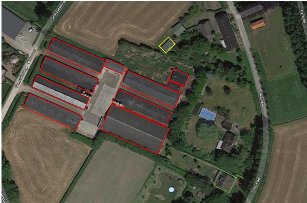
Luchtfoto met aanduiding te slopen bedrijfsbebouwing (rood), te slopen bijgebouw Hezelaar 5 (geel) en de bedrijfswoning (Hezelaar 5a; groen) (bron: maps.google.nl)
