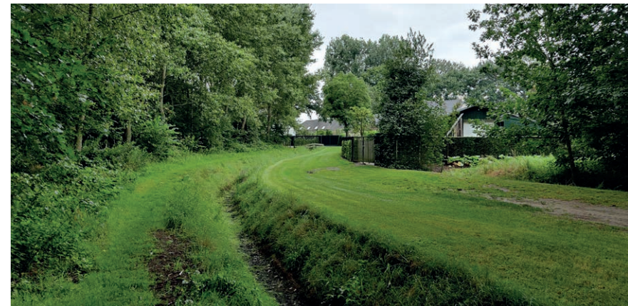
Waterafvoerende sloten in het plangebied
