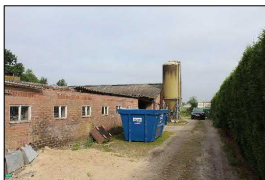
Foto 5. Te slopen varkensstallen
