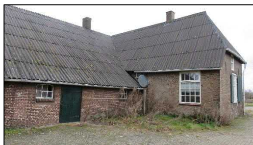
Foto 28. Woonhuis en stalgedeelte
