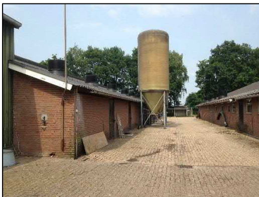
Foto 17. Te slopen varkensstallen
