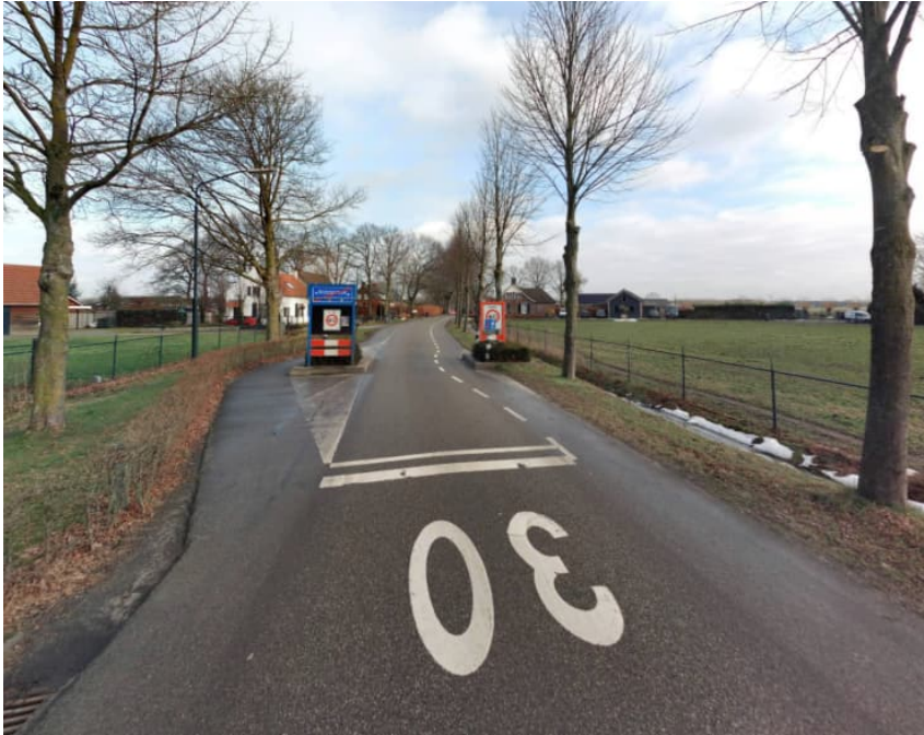
Figuur 14 Huidig wegprofiel Zandstraat ten noorden van Diepven (bron: Cyclomedia, 17-2-2021)
