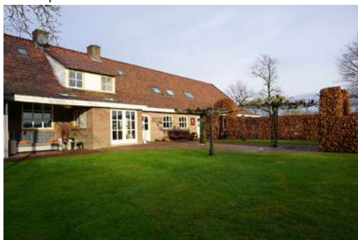
Figuur 2.11 Foto verharding achtergevel foto-opname 29-12-2021
