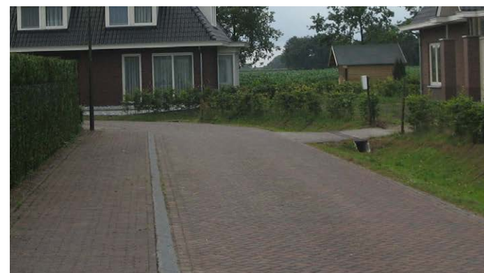
Inrit uitgevoerd in gebakken klinkers en overrijdbare loopstrook
