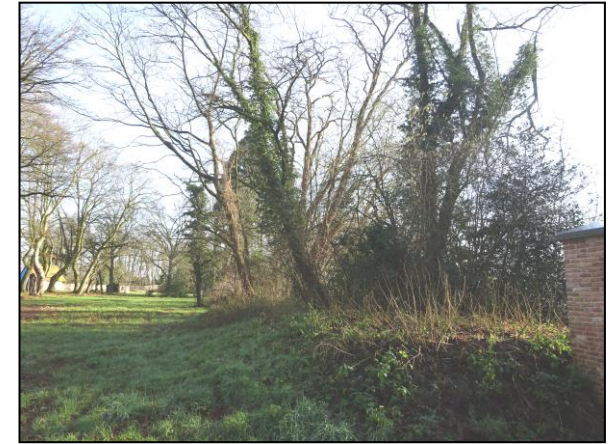
Aansluiting van de zuidelijke kade op de tuinmuur in de zuidwesthoek van de berceautuin.
