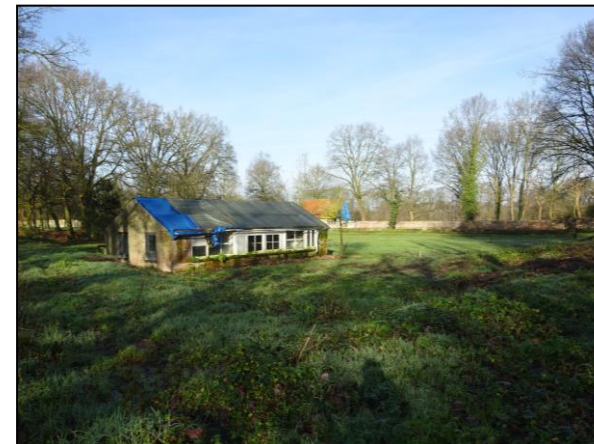
Uitzicht over de moestuin vanaf de zuidoosthoek van de 'kade'. Het gebouw betreft een voormalige kippenschuur.
