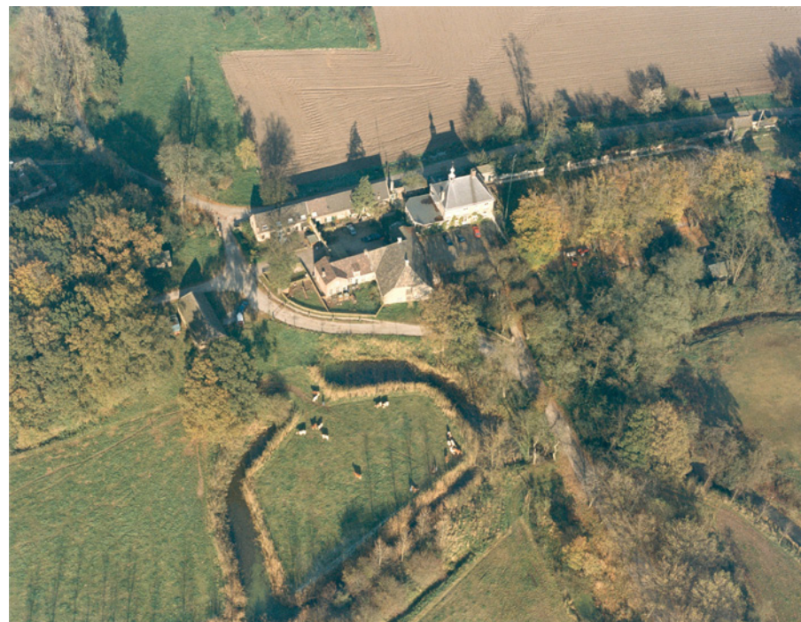
Luchtfoto vanuit het zuidwesten, door Slagboom & Peeters, 1988. Rechts van het huis staat een antennemast en tegen het huis is een pergola aanwezig. Langs de muur loopt een pad, dat ter hoogte van het einde van de berceau afbuigt richting vijver. (Bron: Brabants Historisch Informatie Centrum; www.bhic.nl)
