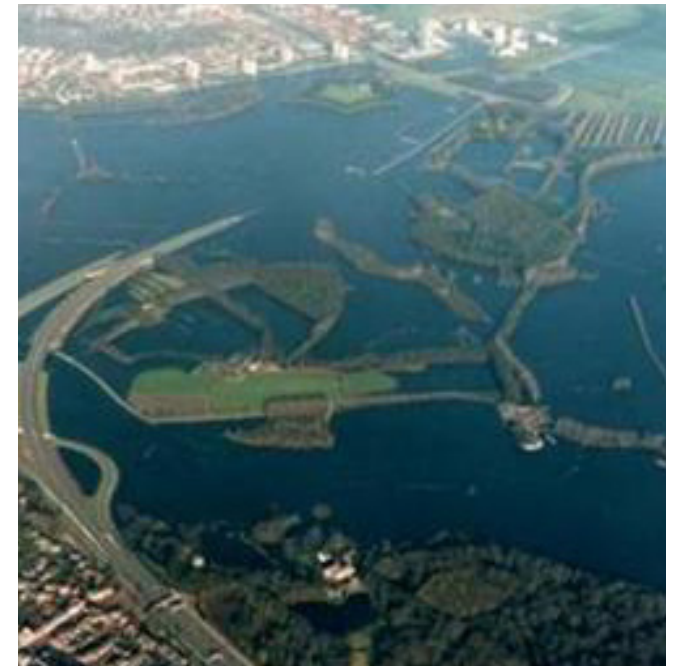
overstroming plangebied met op de voorgrond kasteel Maurick en Out Herlaer, 1995
