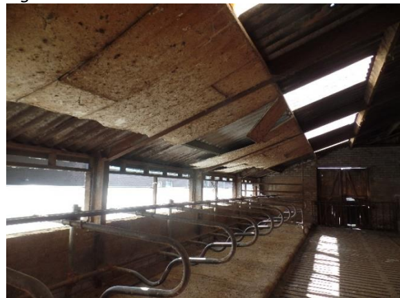
Fig.21. Elders hangen de isolatieplaten los.
