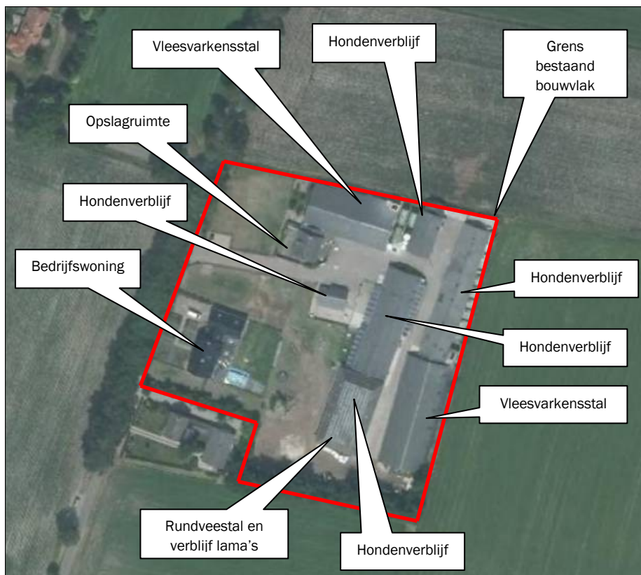
Figuur 4: Luchtfoto bestaande situatie
