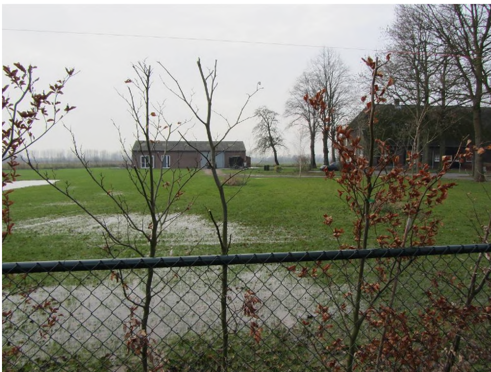
De loods, die vanwege de slechte staat van de boerderij als woning wordt gebruikt, in het grasland
