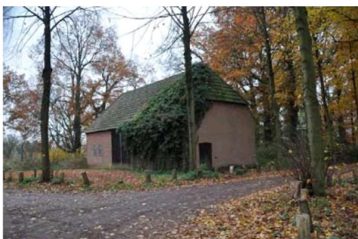
wederopbouwschuur vanuit noordoosten
