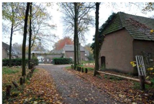
wederopbouwschuur vanuit westen
