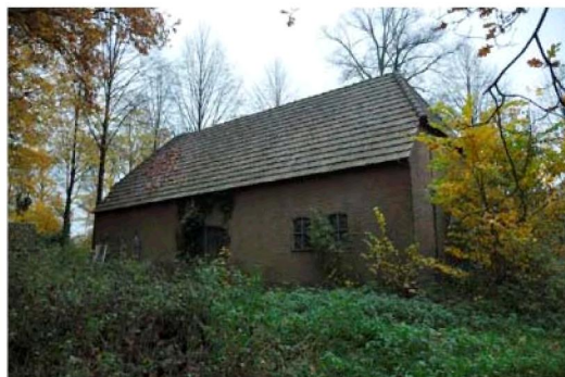
wederopbouwschuur vanuit zuidwesten
