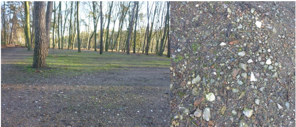
Figuur 5. De halfverharding van puin die is aangebracht om parkeren onder de bomen mogelijk te maken (rechts in detail).
