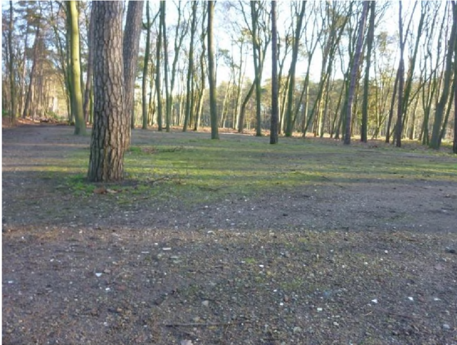
Afbeelding 1.5: De halfverharding van puin die is aangebracht om parkeren onder de bomen mogelijk te maken (rechts in detail).
