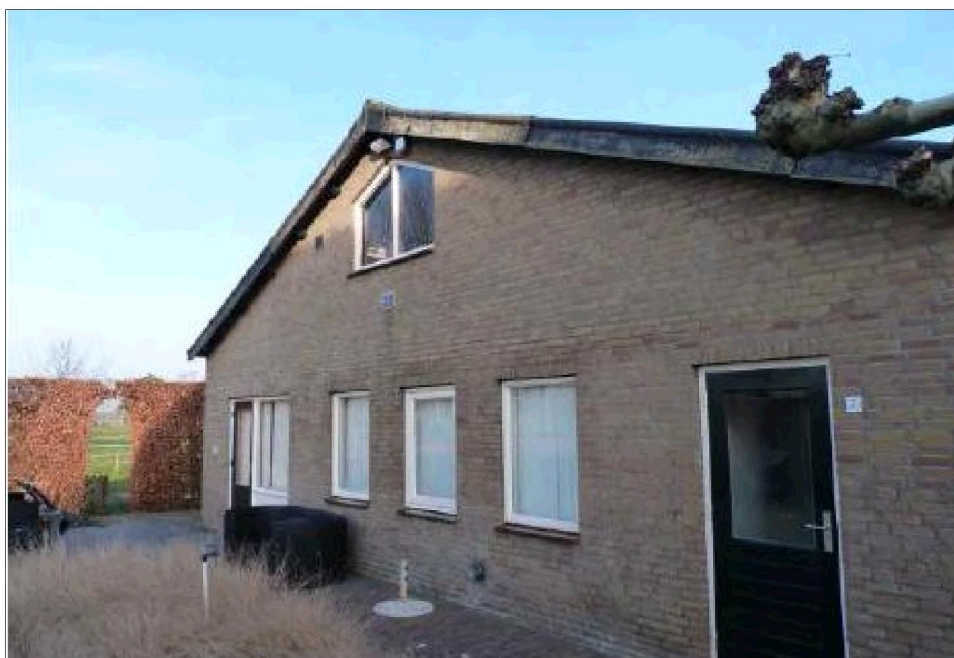
Figuur 3. Vooraanzicht van de te slopen loods
