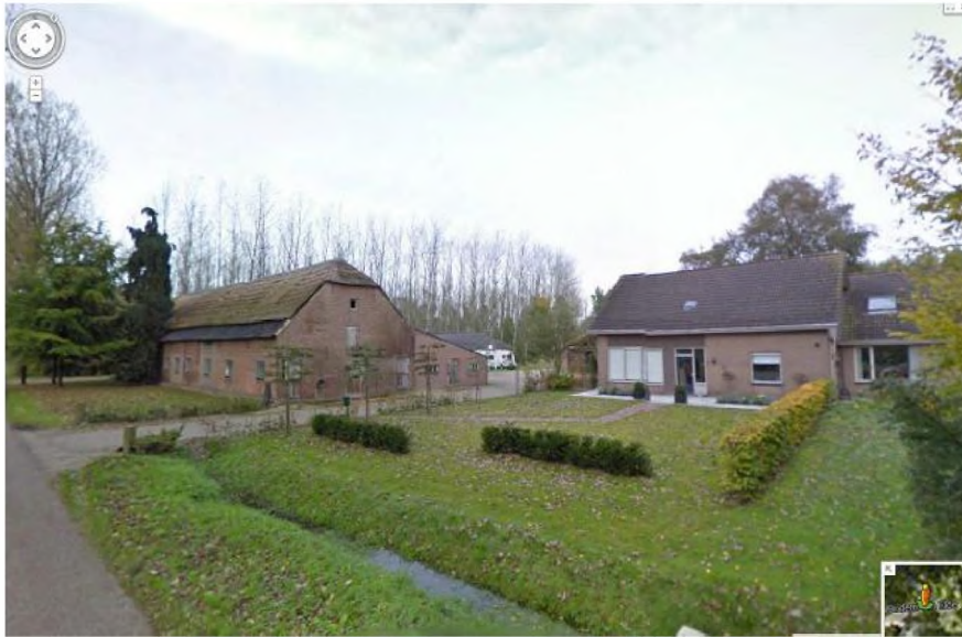
Foto: aanzicht Bodem van Elde 5, de bedrijfswoning en de oude lang gevel boerderij.
