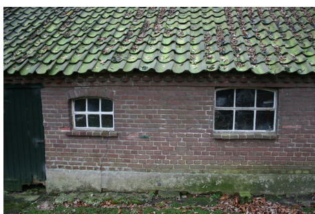
Oorspronkelijk stalraam links, later aangebracht stalraam rechts
