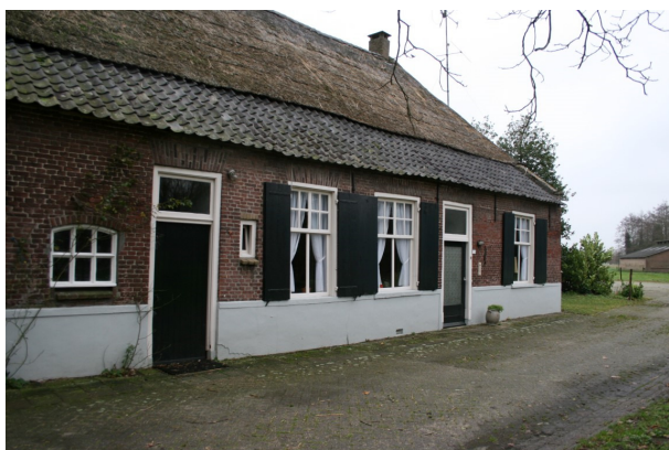
Voorgevel woongedeelte met links vier later aangebrachte openingen
