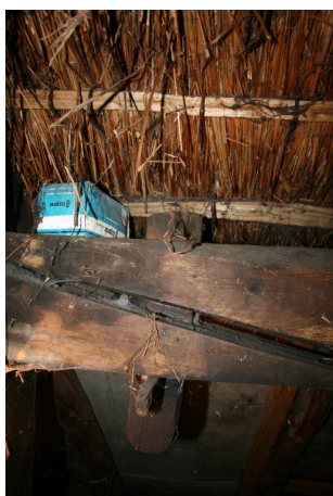
Las met houtverbinding
