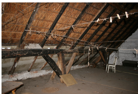
Staanders en gebintplaat op de zolder
