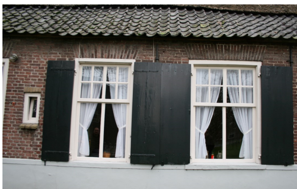
Het later toegevoegde smallere venster links en het venster in de oorspronkelijke opening met oorspronkelijke strek rechts
