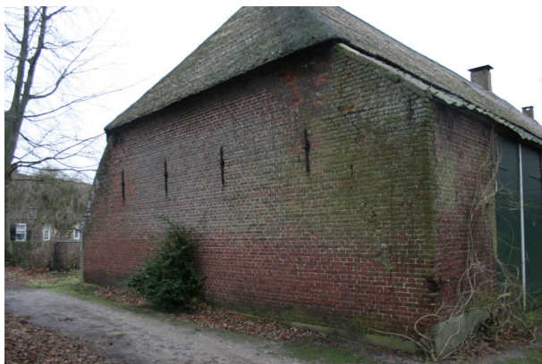
Linkerzijgevel vanaf de straat
