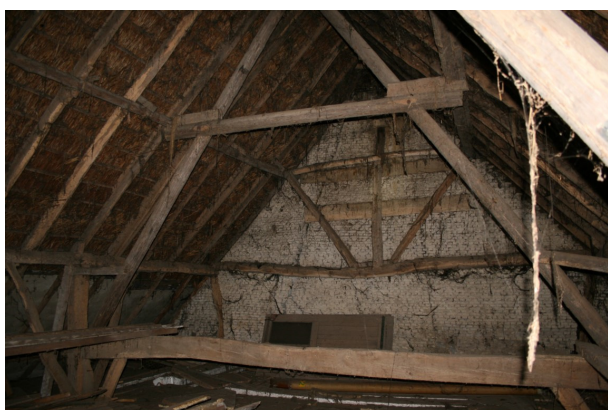
Spant in het achterhuis met achteraan de brandmuur
