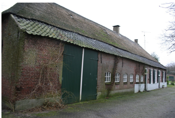
Voorgevel vanaf de linkerzijde. Het vernieuwde vlak is duidelijk zichtbaar.
