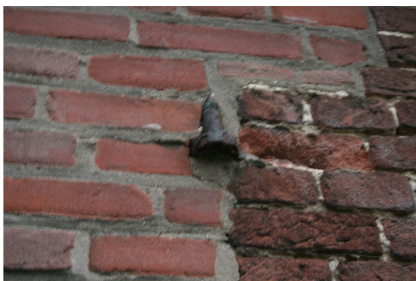
Oorspronkelijke duim in het vernieuwde metselwerk
