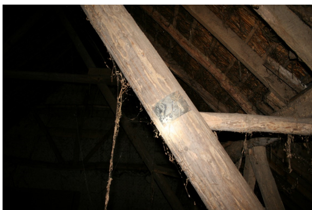
Hergebruikte paal met nummerplaatje (24)
