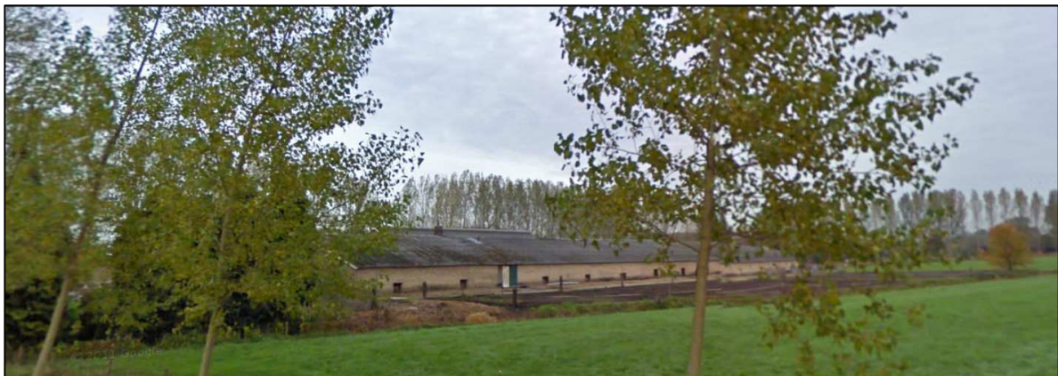
Figuur 9. Foto van de vleeskavelverenstal die gesloopt gaat worden, gezien vanaf de Bodem van Elde (bron: Google Earth).
