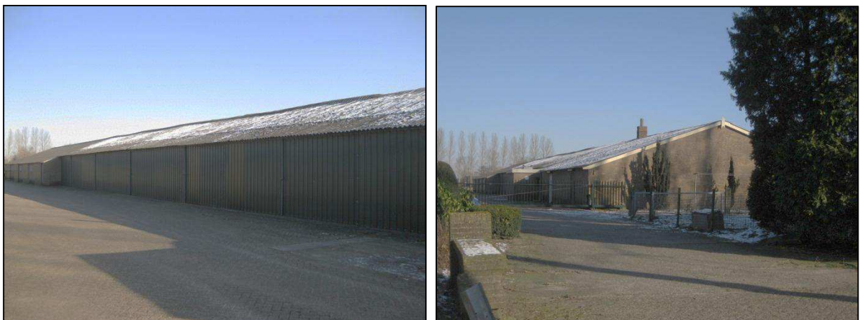
Figuur 10. Foto's van de vleeskavelverenstal die gesloopt gaat worden, gezien vanaf het bedrijfsperceel.
