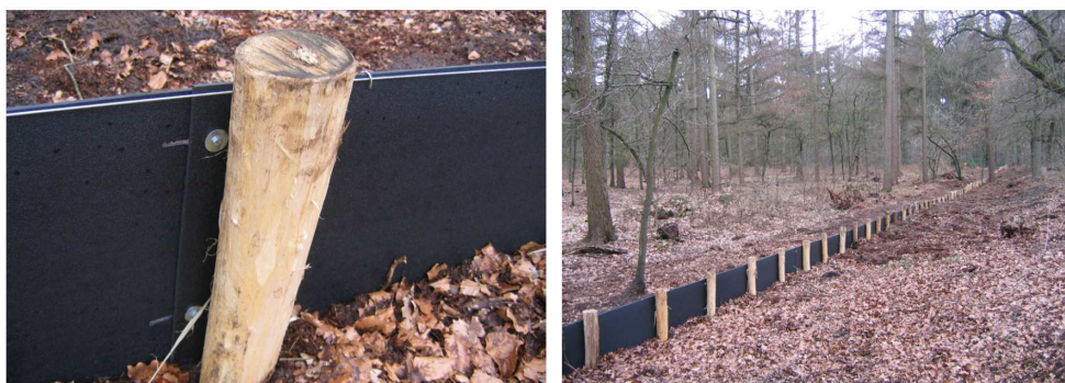
Figuur 5: Voorbeeld eenvoudig amfibieënscherm met ruimte voor werking zodat de werking van krimp en uitzetting kan worden opgevangen.
