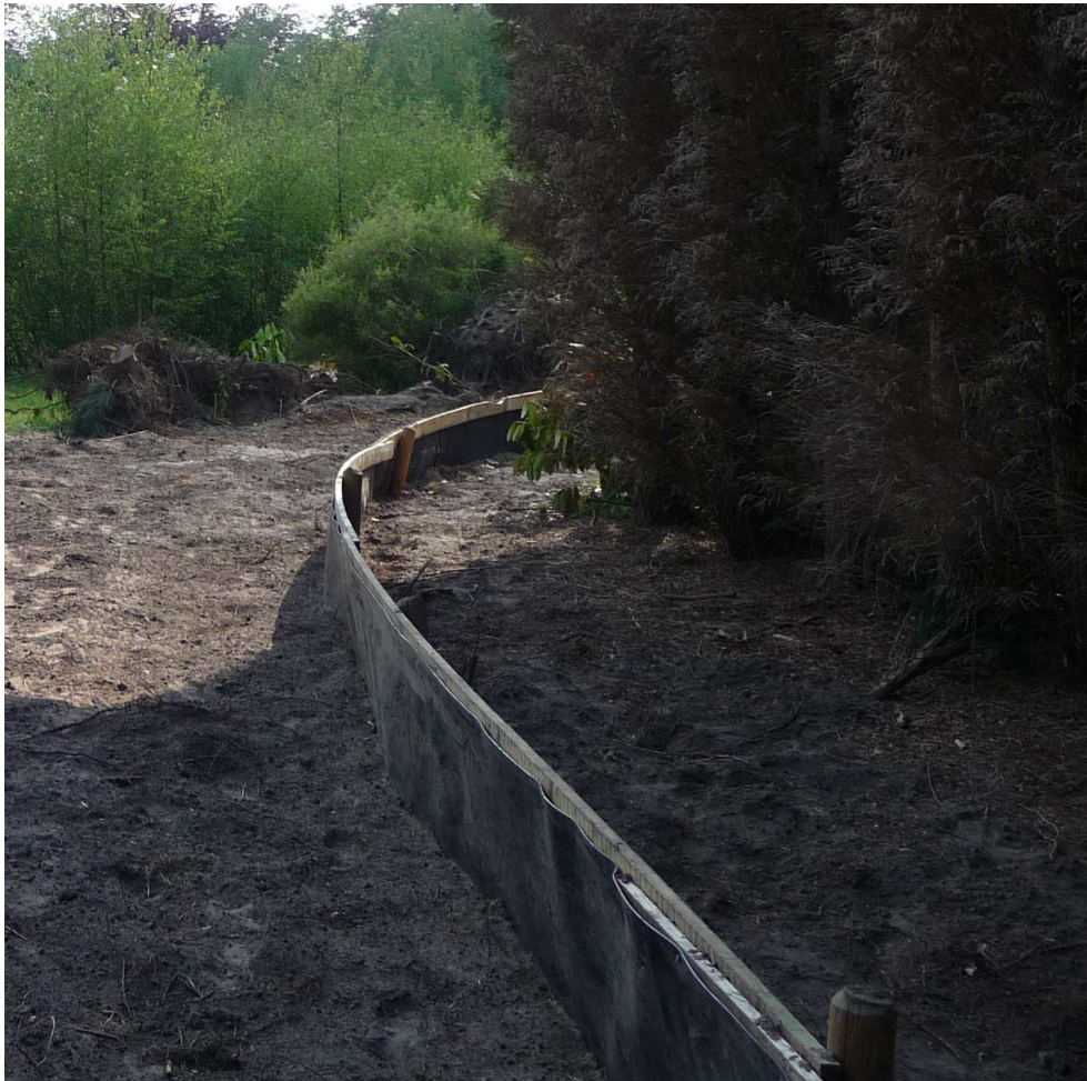
Figuur 5. Voorbeeld tijdelijk amfibiescherm dat is geplaatst in plangebied.
