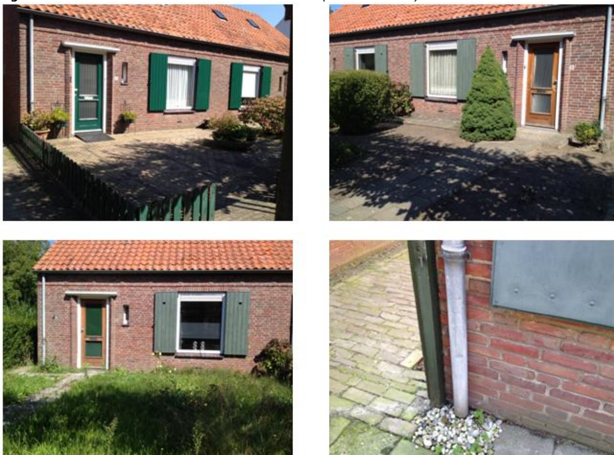
Figuur 5: foto's hemelwaterafvoer onderzoekslocatie (bron: MILON BV)
