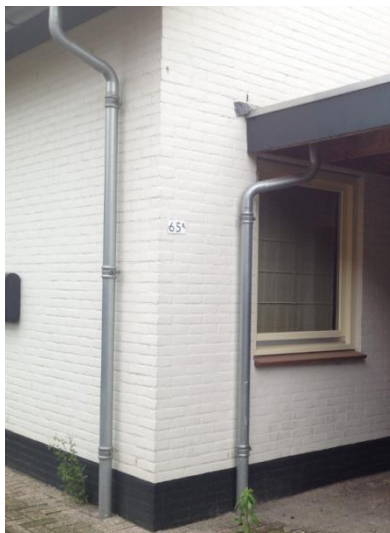
Figuur 4: Foto hemelwaterafvoer. (bron: MILON bv)
