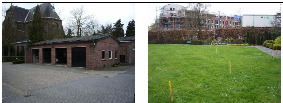
Figuur 3.1 Overzicht van het plangebied: een ommuurd kloosterterrein aan de Mieke de Brefstraat te Volkel (05-04-2012). De linker foto toont het oostelijke deel met het parkeerterrein en de garages en het stookhok. Deze gebouwen worden afgebroken. De rechterfoto toont een deel van de westelijke kloostertuin. De stokjes zijn verdachte locaties uit het explosievenonderzoek.
