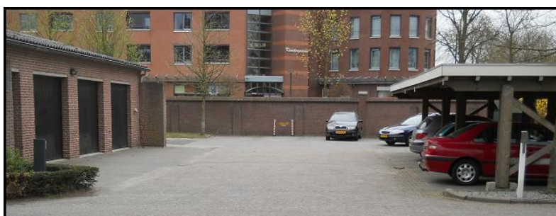
Figuur 3: Overzichtsfoto van de onderzoekslocatie.
