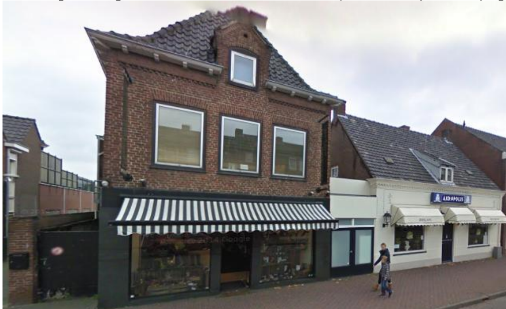
Afbeelding 1: Voorgevel bestaande situatie – links: 162; rechts 164 (bron: maps.google.nl)
