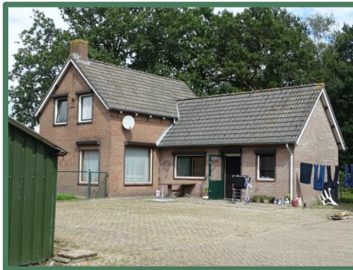
Woning turfstraat 6 vanuit het zuidoosten
