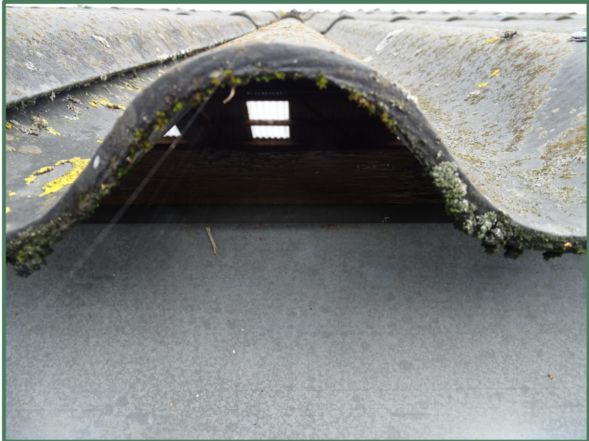
Uitzicht op het dak vanuit de buitenzijde
