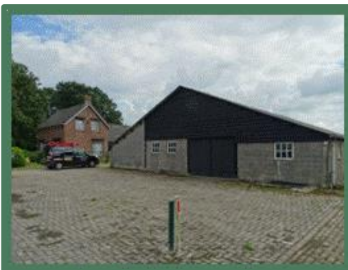
Voormalige rundveestal vanuit het noorden
