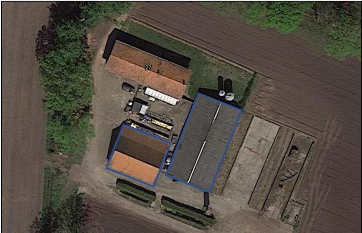
Afbeelding 3: Gebouwen t.b.v. statische opslag
