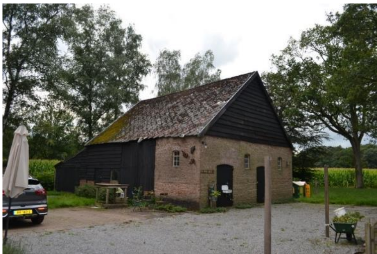
Schuur uit de bouwtijd, met latere aanbouw.
