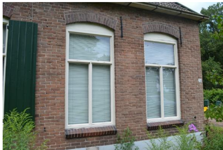
Later verlengd woondeel met dubbel T-venster.
