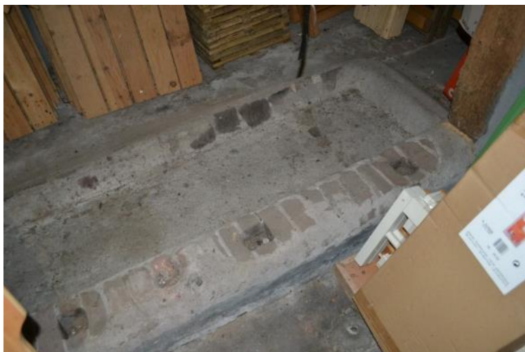
Gemetselde voerbak in betonvloer.
