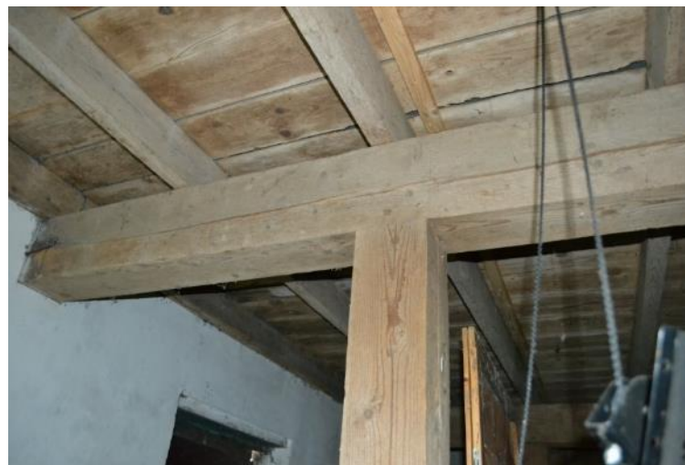
Houten constructie van dekbalk en kolom.
