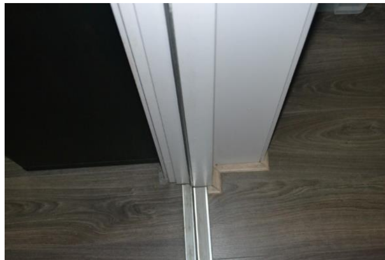
Binnendeur in voormalige buitengevel.
