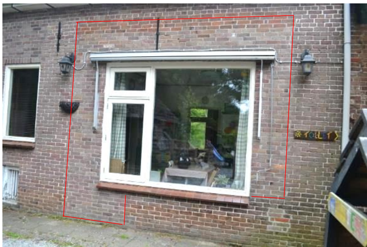
Vernieuwd keukenvenster en inboetwerk (rood aangegeven).
