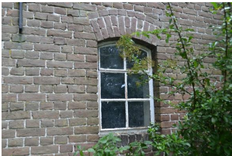
Stalen stalvenster met kiepraam.
