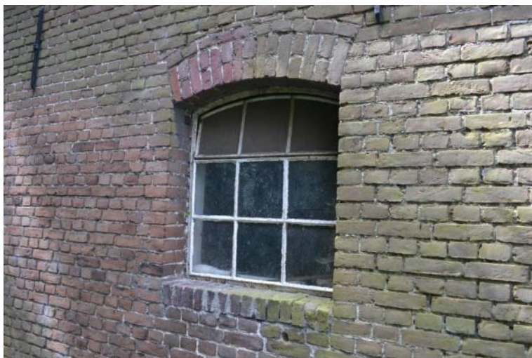
Stalen stalvenster in bedrijfsdeel.
