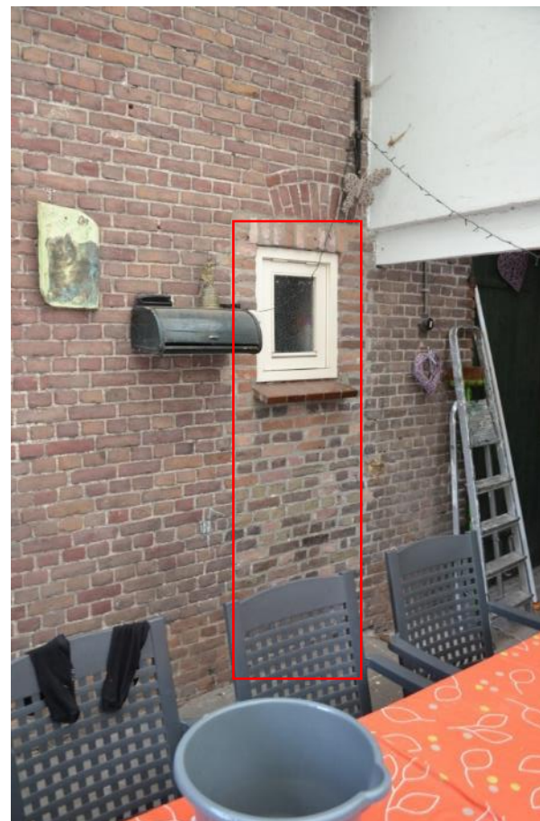
Later aangebracht toiletvenster met inboetwerk (rood).
