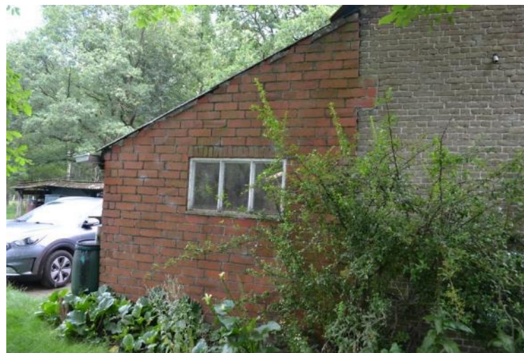
Aanbouw aan linkerzijde, met betonvenster.
