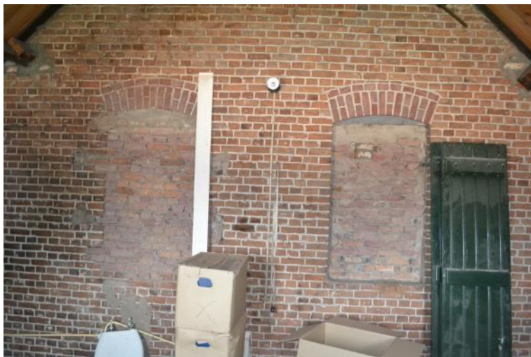
Dichtgezette oorspronkelijke gevelopeningen in oorspronkelijke buitengevel.
