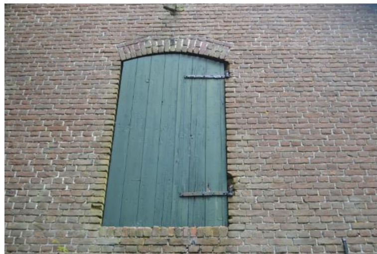
Opgeklampte houten hooiluik op verdieping.
