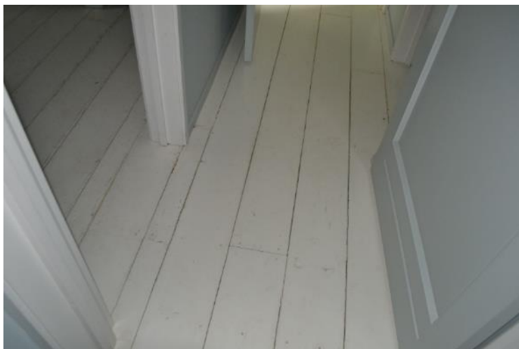
Oorspronkelijke vloerdelen met nieuwe binnenwanden.
