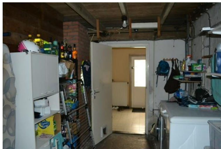
Later geplaatste wanden in rechter travee.
