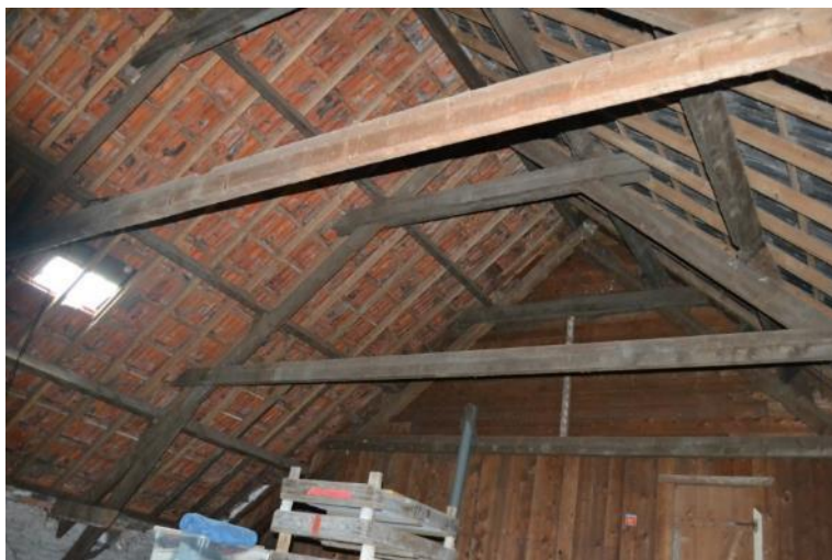
Houten spantconstructie met onbeschoten kap.
