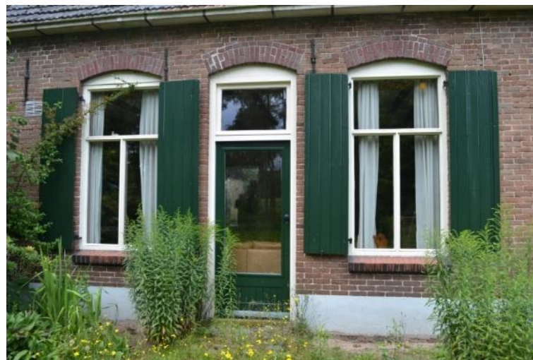
Oorspronkelijke woondeel, met vernieuwde voordeur en T-vensters met luiken.
