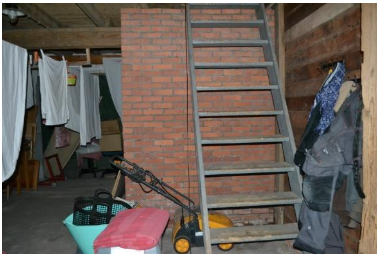
Later geplaatste wanden en houten trap.
