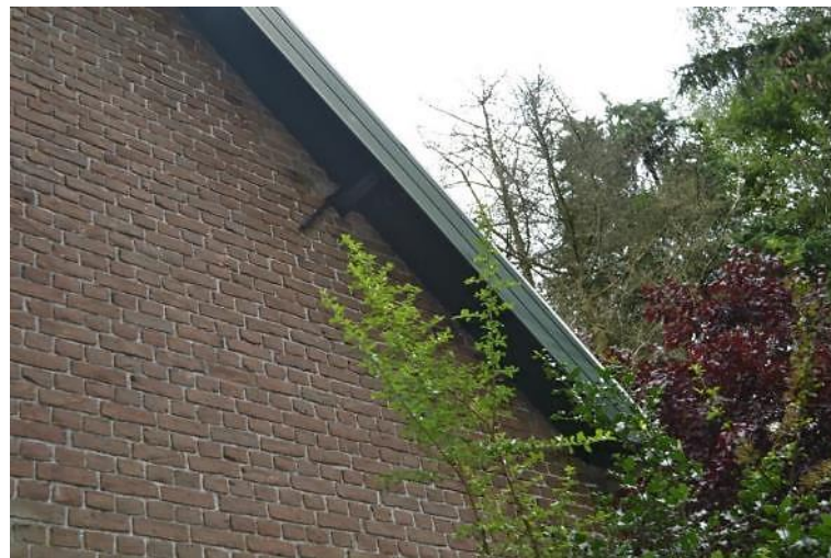
Later aangebrachte overstekende houten windveer met waterbord.
