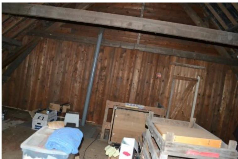
Houten tussenwand op verdieping van het bedrijfsdeel.
