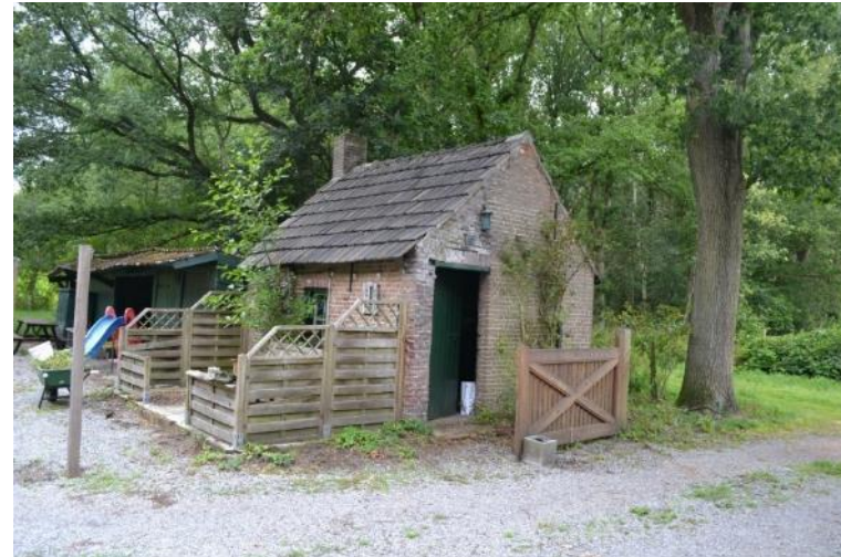
Vermoedelijk bakhuis uit de bouwtijd, met later geplaatst bijgebouw aan de achterzijde.
