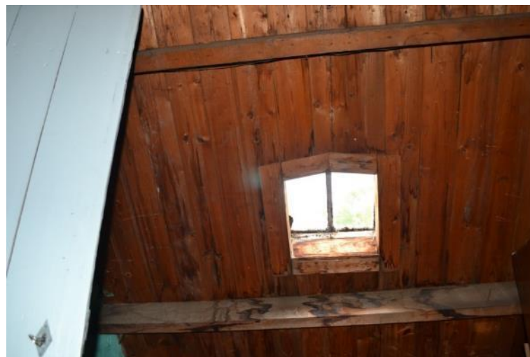
Staan dakbeschot tegen kap.
