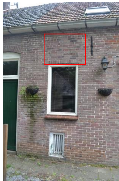
Vernieuwd venster met inboetwerk Achterdeurkozijn. (rood) erboven en beneden het keldervenster uit de bouwtijd van de boerderij.
