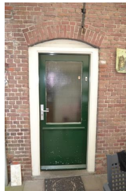
Vernieuwd venster met inboetwerk Achterdeurkozijn. (rood) erboven en beneden het keldervenster uit de bouwtijd van de boerderij.
