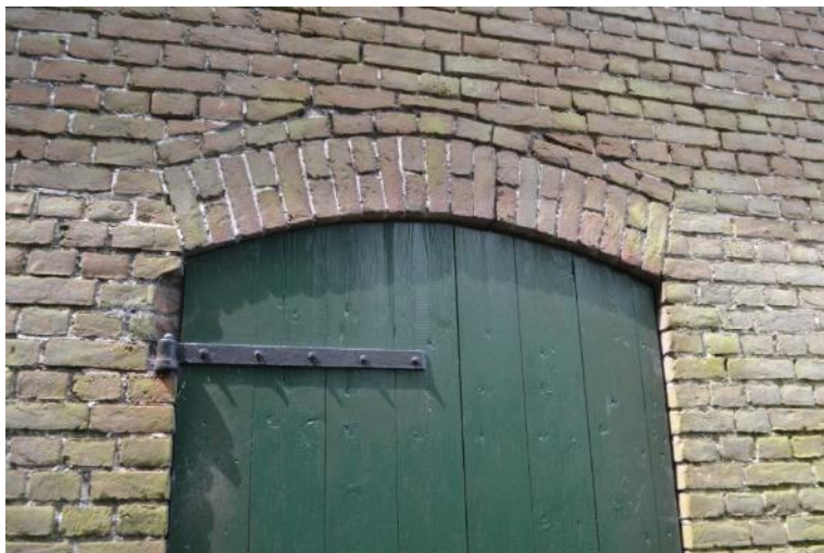
Houten staldeur in bedrijfsdeel.
