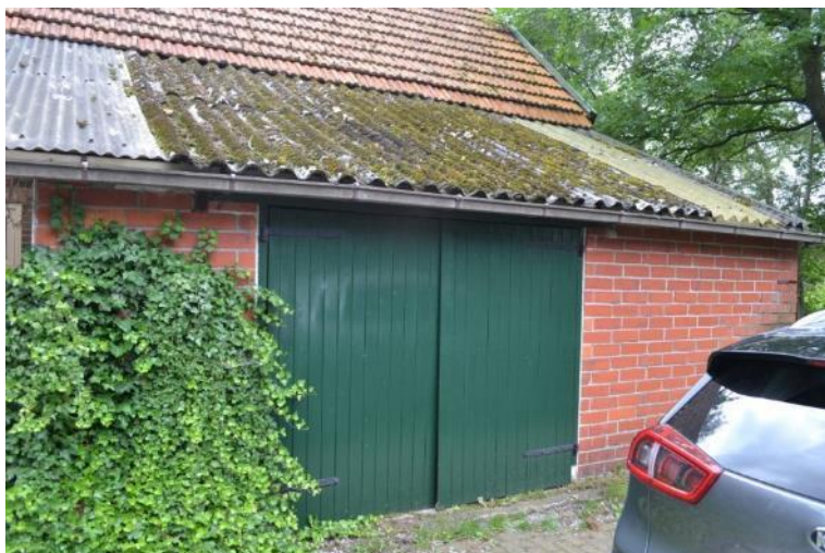
Dubbele deuren in latere aanbouw.
