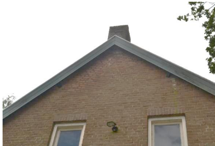
Eenvoudige windveer en inboetwerk in het metselwerk.
