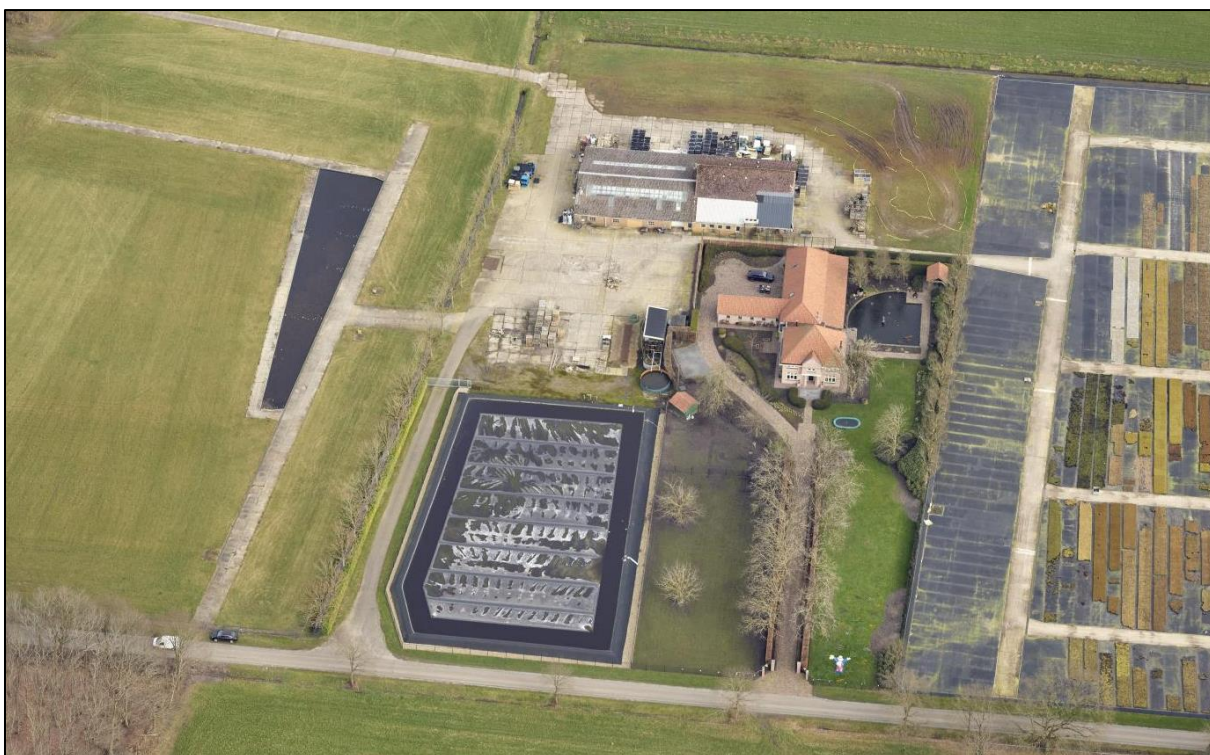
Afbeelding 10 - Bedrijfswoning en loods plangebied (locatie 2)
