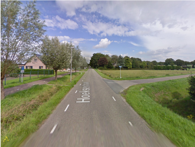
Hoeksestraat richting oosten
