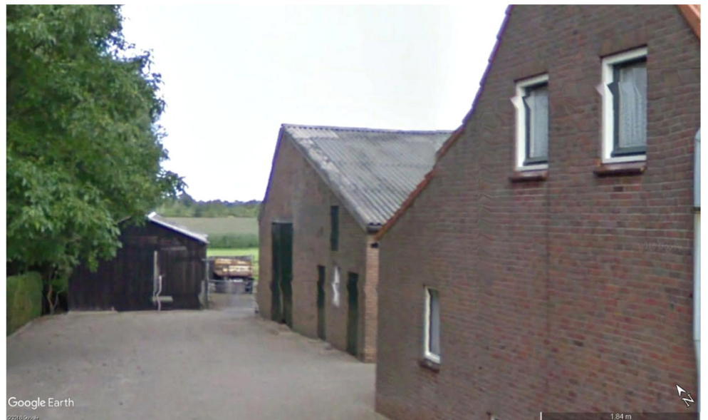
de gesloopte schuren, asbest-daken en dakgoten
